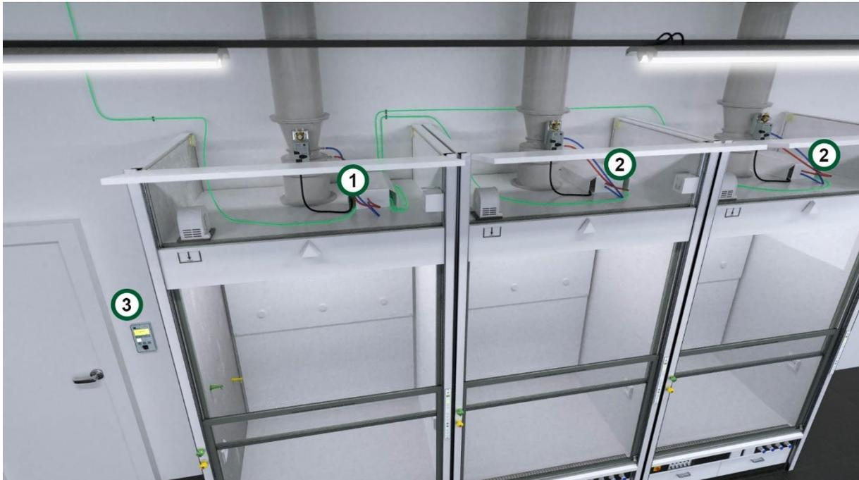
Abbildung 13, Standardlabor mit Bilanzierung über Raumadditionsmodul
