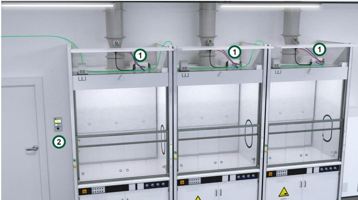
Abbildung 14, Standardlabor mit Vernetzung und Bilanzierung über Modbus
